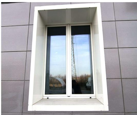
4. **Installazione di faldaleria pressopiegata in acciaio zincato preverniciato** di colore RAL a scelta della D.L. a costituire imbotti, architravi e davanzali delle finestre interno cortile dei prospetti evidenziate negli elaborati grafici sui prospetti "C", "D", "E", "F", "G".
