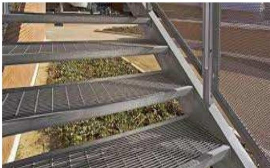
5. **Sostituzione delle scale esterne per uscite di sicurezza**, di collegamento tra il piano rialzato e il cortile interno al fabbricato, aventi passaggio netto minimo di mm 1200
