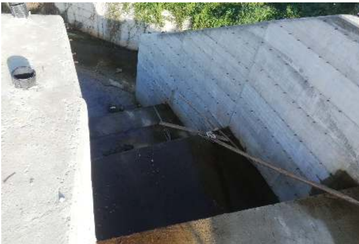
Foto 12 – (31-12-2020) Tratto completato di canale L-M allo sbocco della nuova opera in c.a. nel canale in c.a. esistente.
