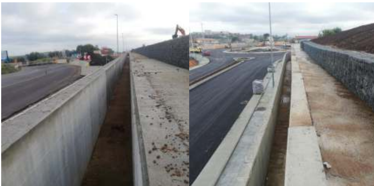
Foto 1 e 2 – (31-12-2020) Tratto completato di canale A-B-C prospiciente a Via Giustino Fortunato.
