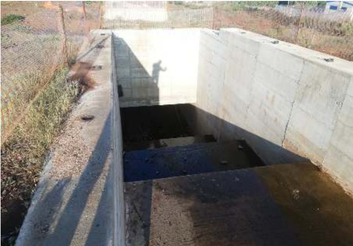
Foto 9 – (31-12-2020) Tratto completato di canale L-M in c.a. per l'attraversamento di Via Cocari.
