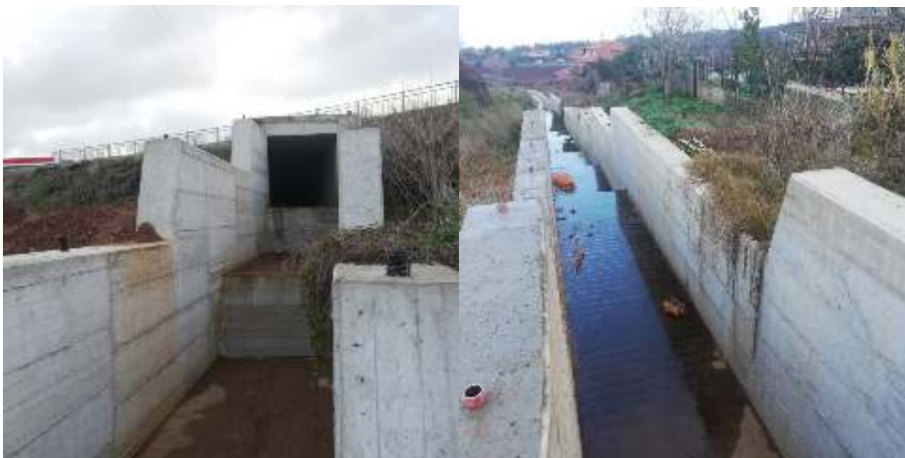
Foto 3 e 4 – (31-12-2020) Tratto completato di canale C'-D-G a valle di Via Giustino Fortunato.
