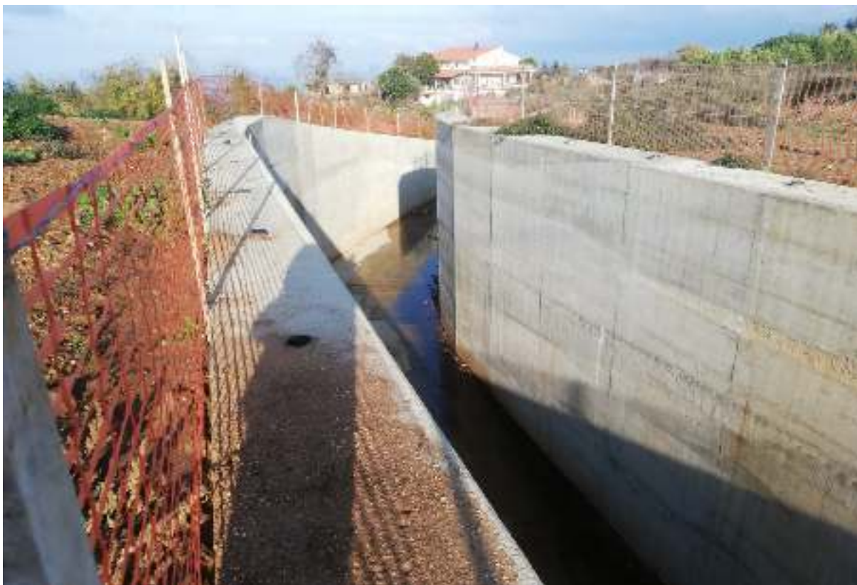
Foto 11 – (31-12-2020) Tratto completato di canale L-M in c.a. a valle di Via Cocari.
