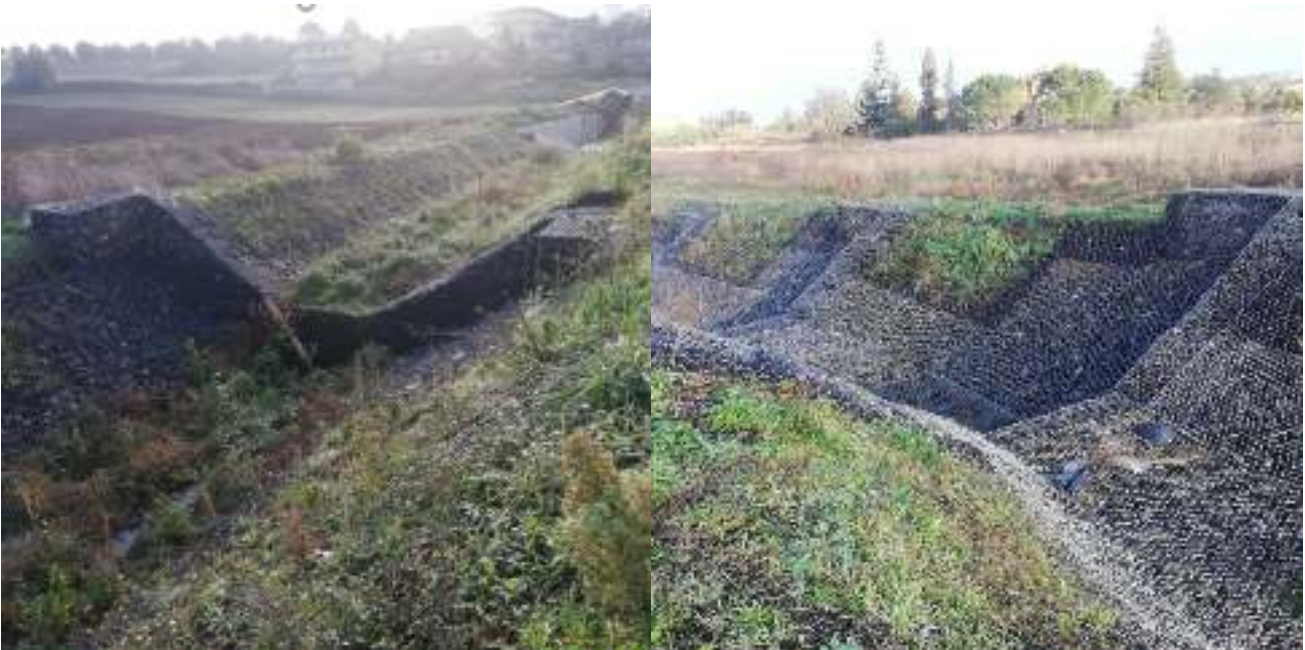
Foto 7 e 8 – (31-12-2020) Tratti completati di canale I-L in materassi tipo Reno, salti di fondo e briglie in gabbioni.
