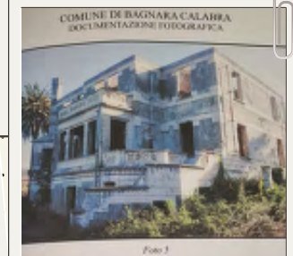
Stato di fatto pre intervento
