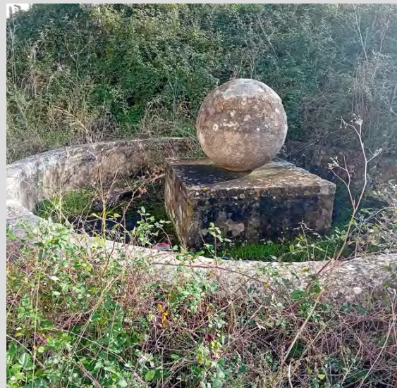
La fontana del giardino non è stata recuperata perchè i fondi non sono stati sufficienti.
