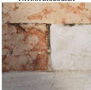
DECOESIONE DELLE MALTE DI ALLETTAMENTO
