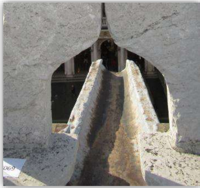
Foto esemplificativa di un doccione funzionante del prospetto .
