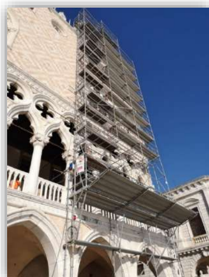
Ponteggio montato a regola d'arte per il cantiere pilota
