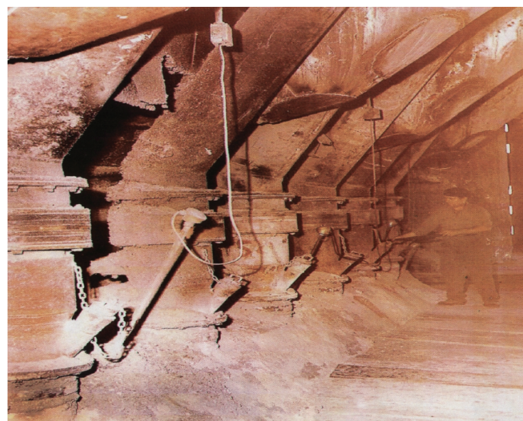
Il reparto forno fosforo dell'ex Montedison di Crotona
