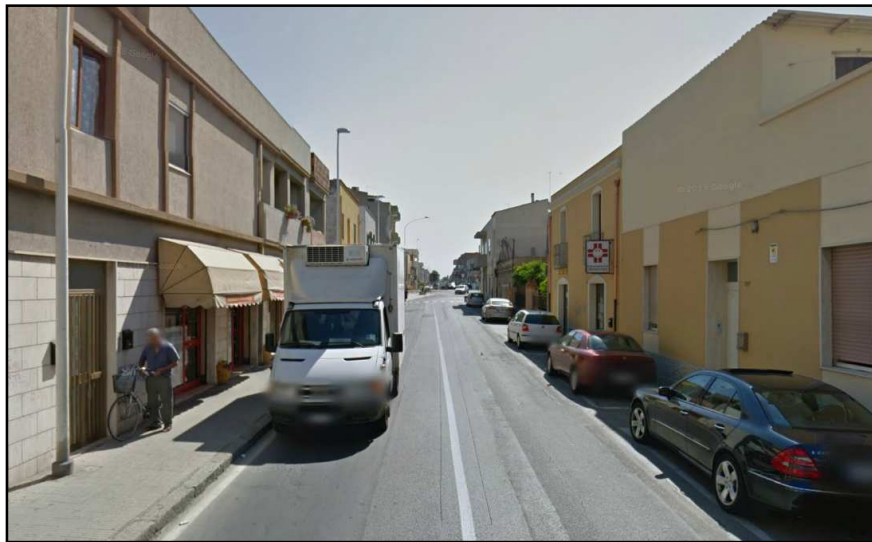
Figura 65 - Via Zuddas pressi rotonda di via Riu Mortu: assenza di marciapiede sul lato destro
