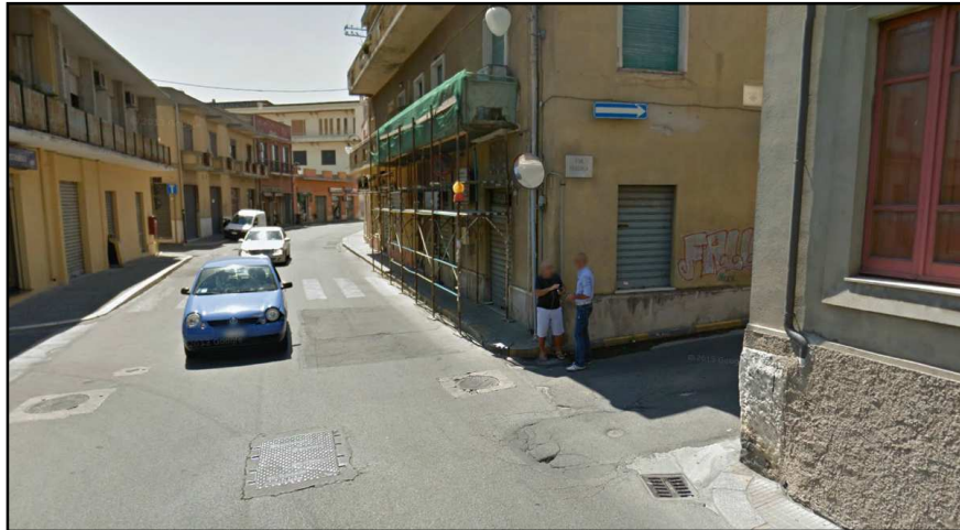
Figura 64 - Via del Redentore pressi intersezione con via Deroma: marciapiede di sezione ristretta sul lato destro
