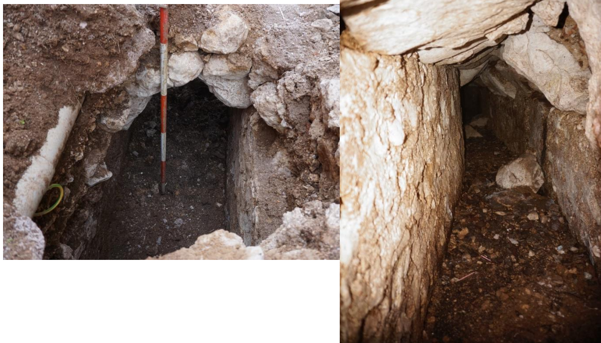
Figura 12 Dettaglio ed interno condotta 2.
