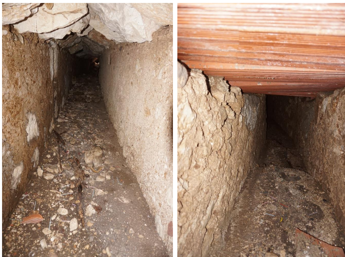
Figura 13 Copertura originaria condotta Est (a sinistra), sostituzione della copertura originale (destra).
