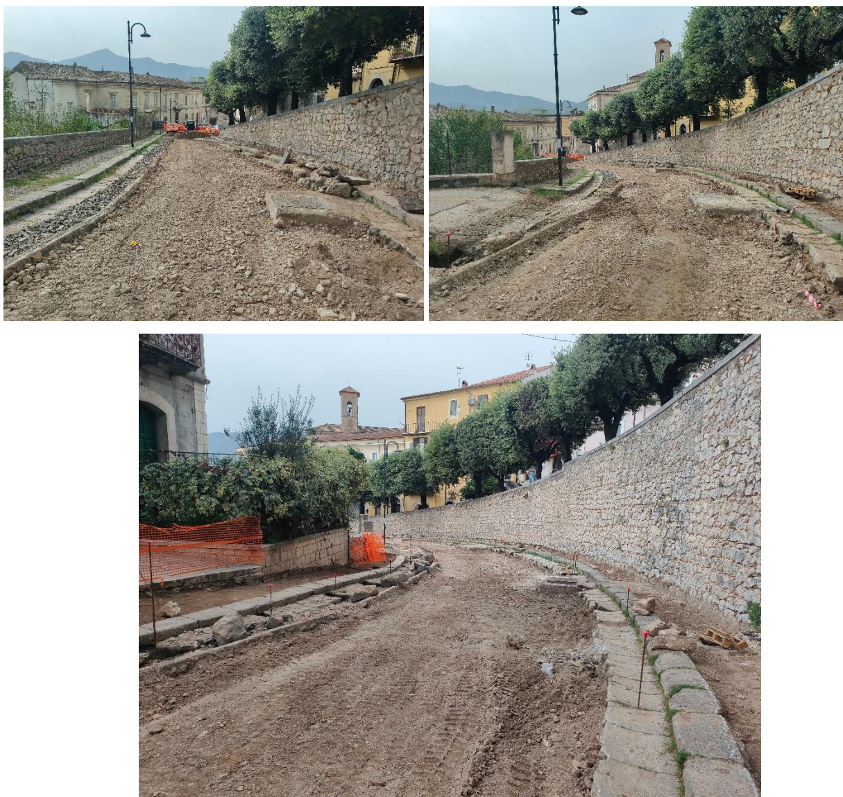
Figura 2. Panoramiche Via Caserta a seguito della rimozione del tappetino di asfalto.
