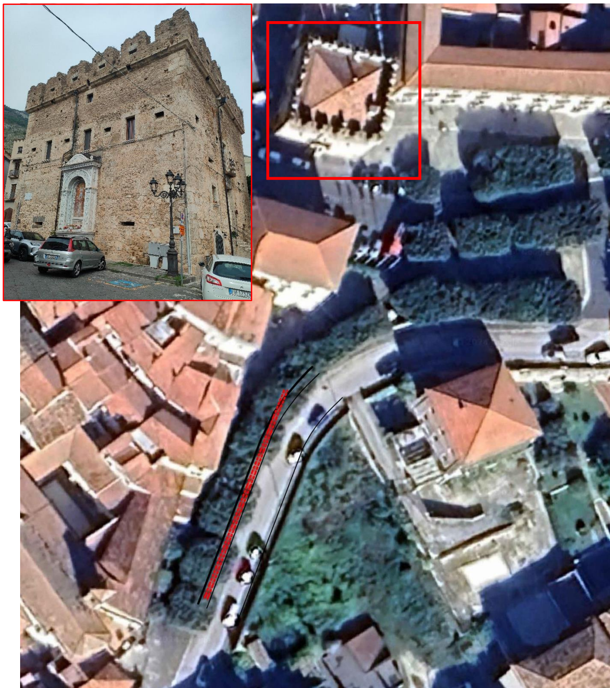
Figura 8. Percorso condotta con veduta della Torre di Palazzo Cimorelli.
