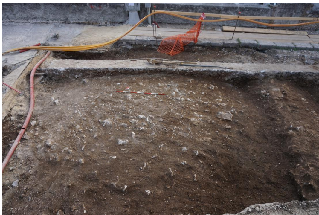
Figura 15. Ambiente voltato a vela via Caserta.
